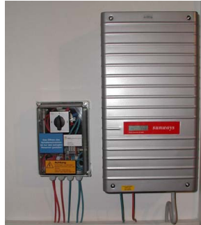
Interruptor principal separado antes del inversor
