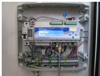
Registrator de datos (datalogger)
